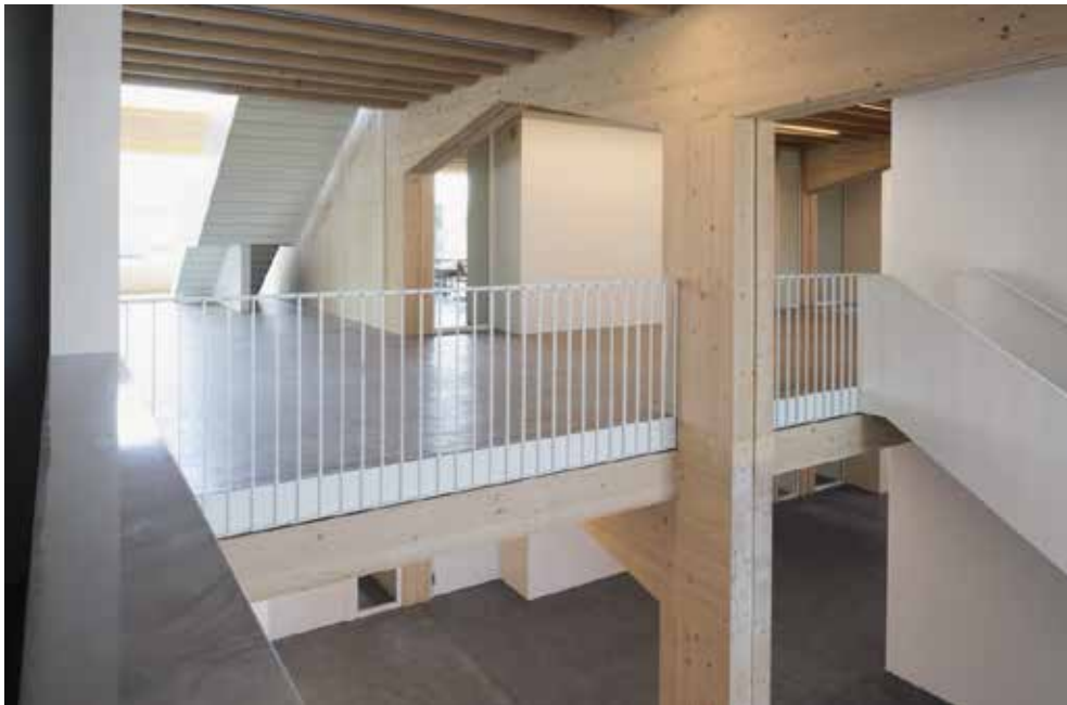
L'école a été entièrement construite avec du bois local. La structure primaire est constituée de poutres équarrées.
