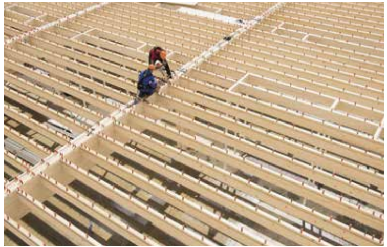
L'école a été entièrement construite avec du bois local. La structure primaire est constituée de poutres équarrées.
